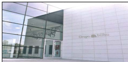
Figura 4. Fachada de cerámica fotocatalítica del Grupo Bilbu en Bilbao. Fuente: Ceracasa
